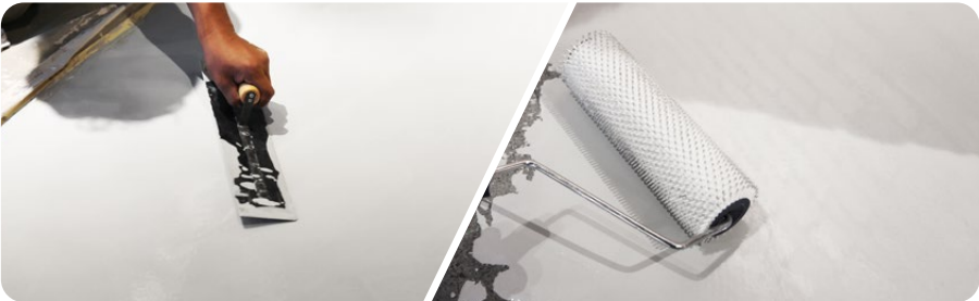
STEP 2 : MOISTURE BARRIER
