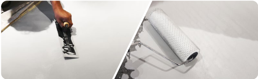
STEP 2 : MOISTURE BARRIER
